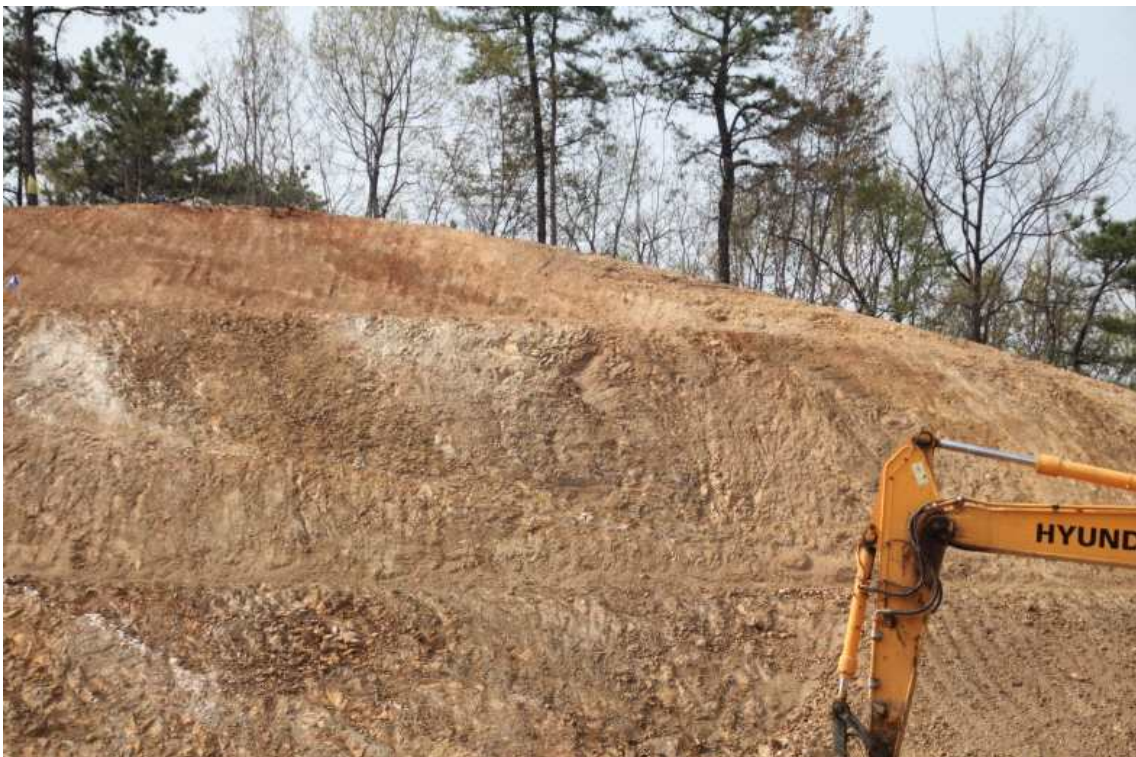
STA.8+850 상단부 녹화전
