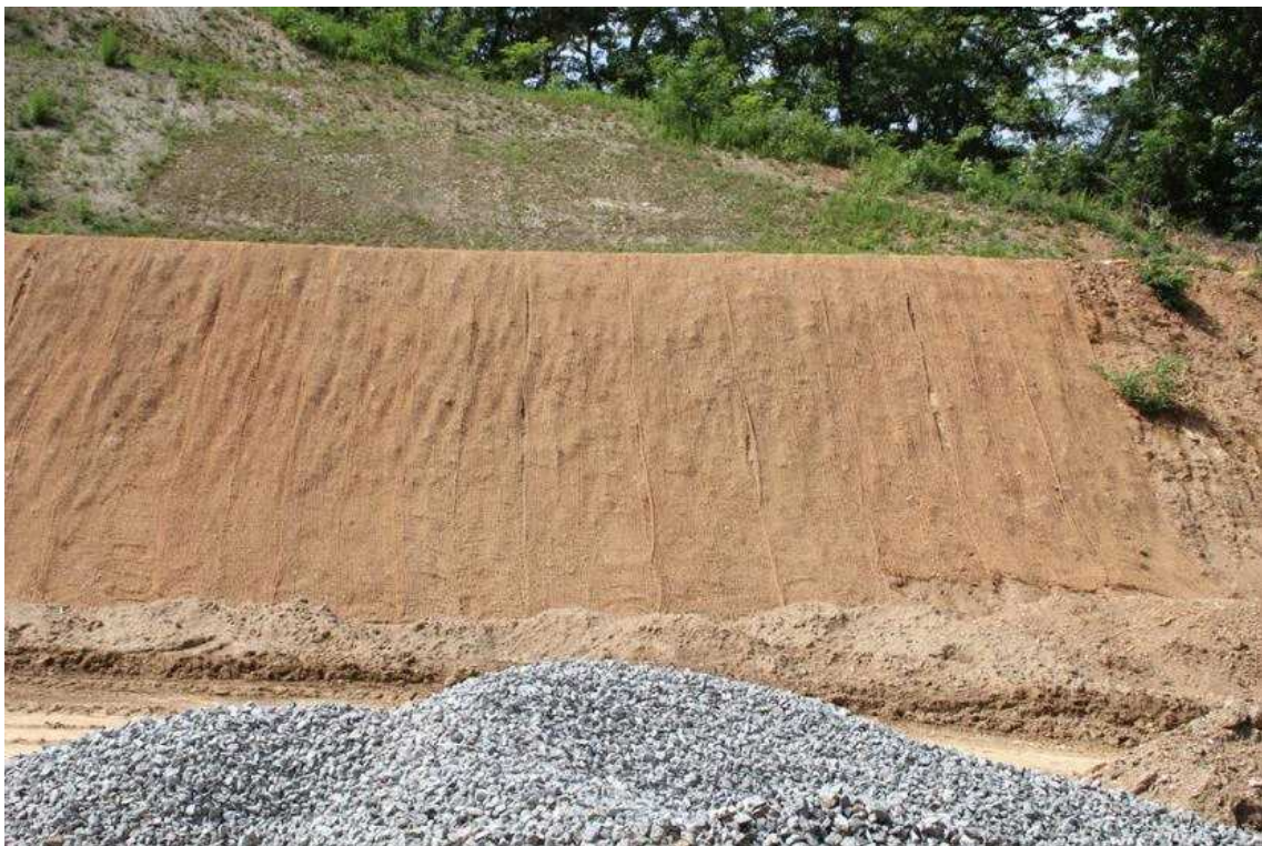
STA.8+870 하단부 녹화후
