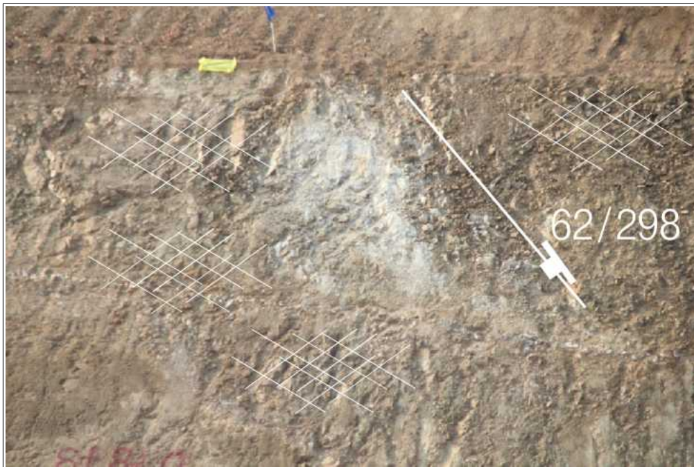
【그림 14】 B 영역에 발달한 불연속면
