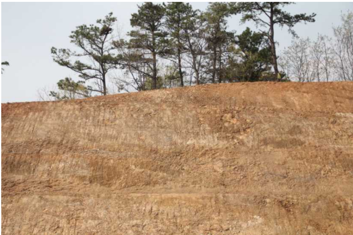
STA.8+830 상단부 녹화전
