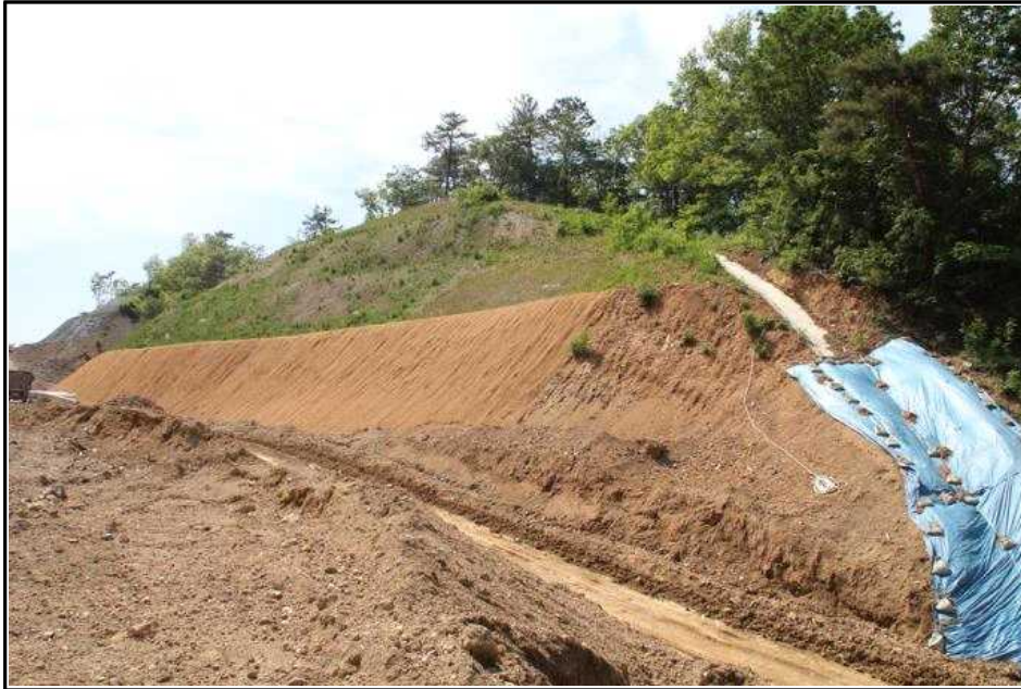
【그림 3】 깎기비탈면 시점부 측면 사진
