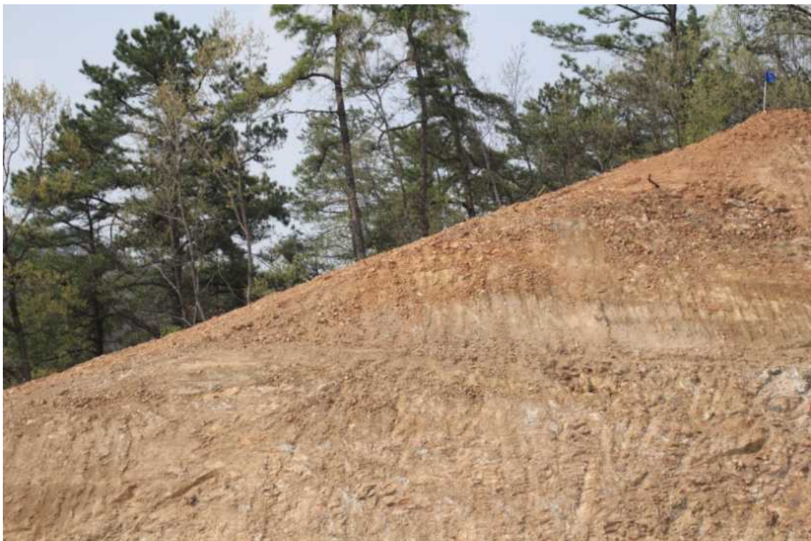
STA.8+810 상단부 녹화전
