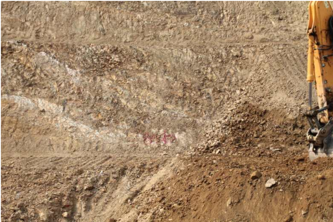
STA.8+850 하단부 녹화전
