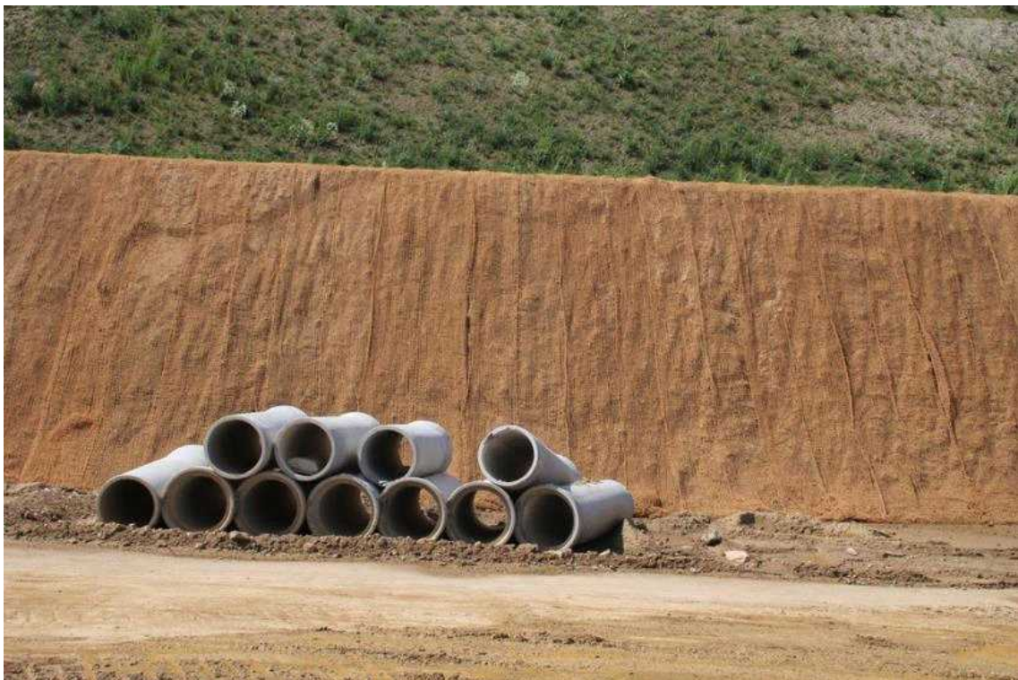
STA.8+830 하단부 녹화후
