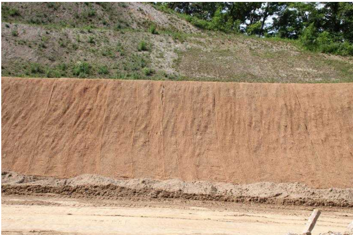
STA.8+860 하단부 녹화후
