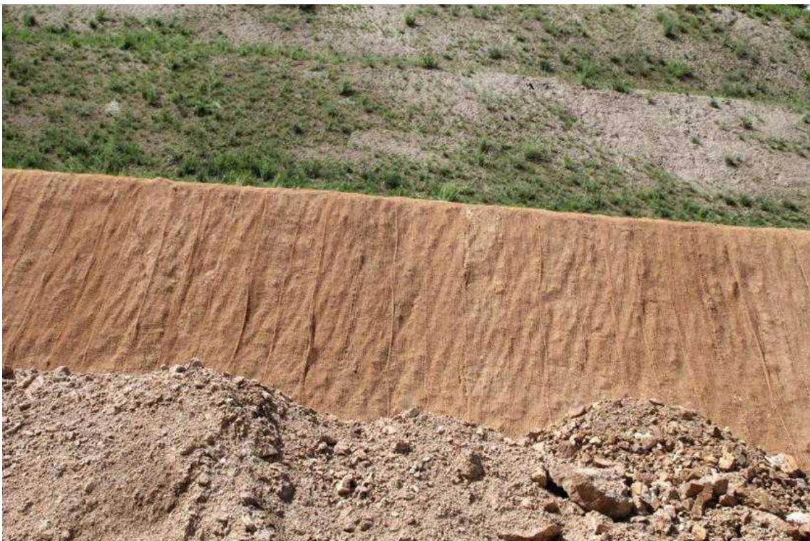
STA.8+840 하단부 녹화후
