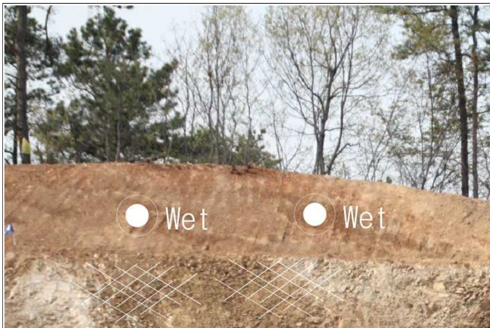
【그림 18】 B 영역 상세사진 (세편화된 암석 및 지하수 유출)
