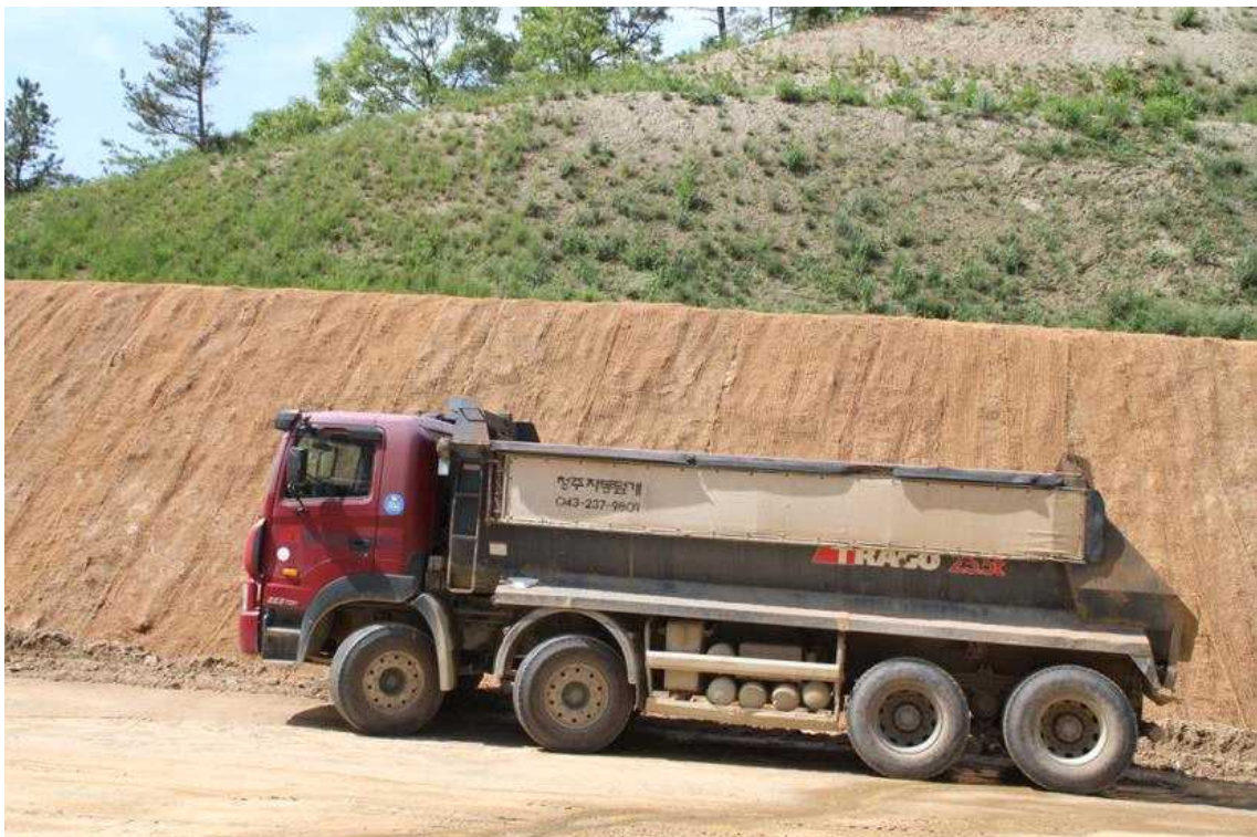
STA.8+810 하단부 녹화후
