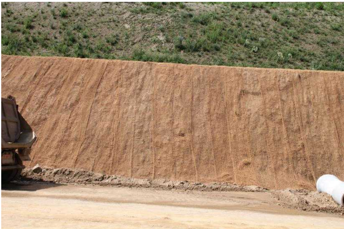
STA.8+820 하단부 녹화후
