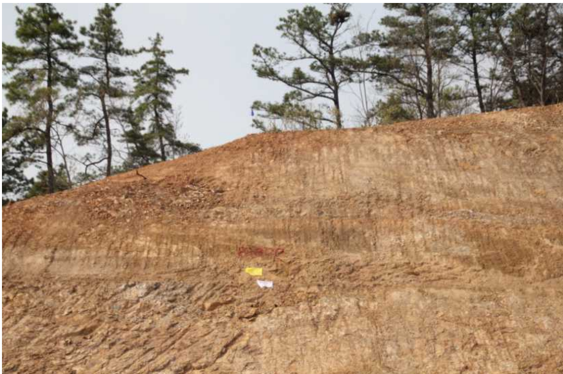
STA.8+820 상단부 녹화전
