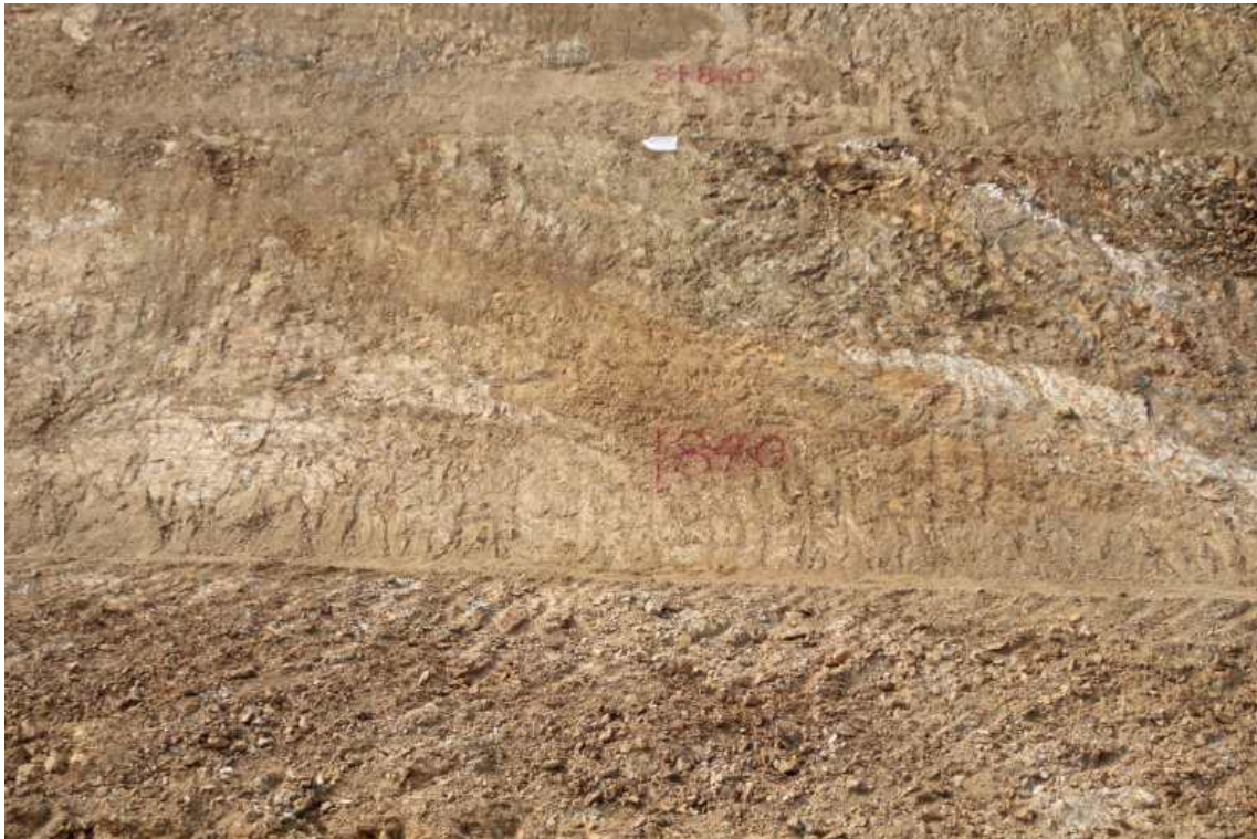
STA.8+840 하단부 녹화전
