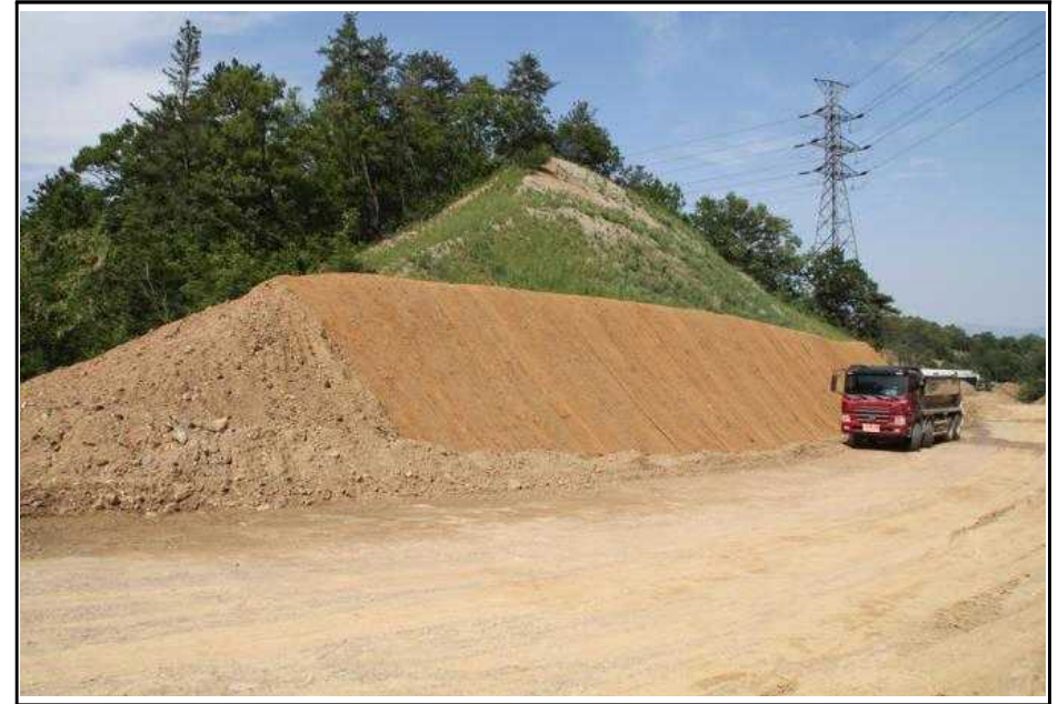
【그림 4】 깎기비탈면 종점부 측면 사진
