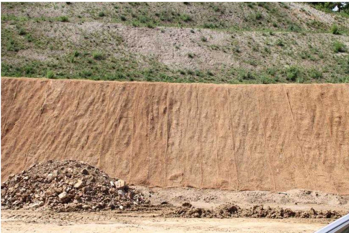
STA.8+850 하단부 녹화후
