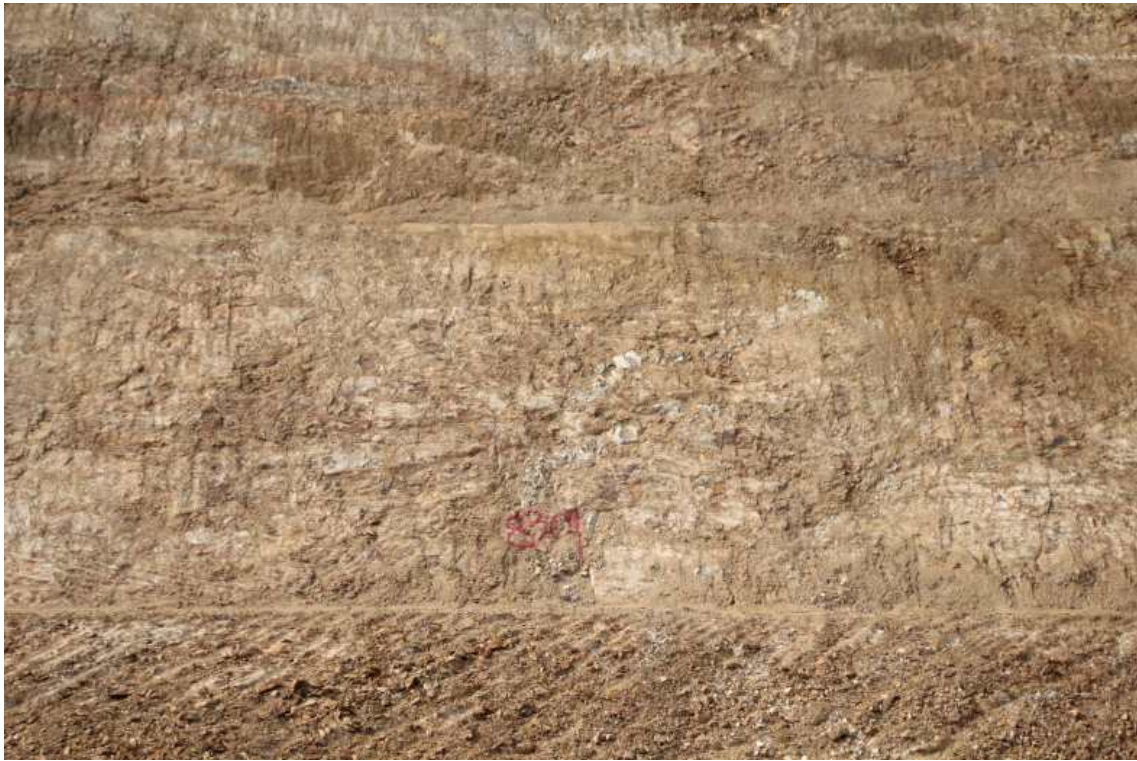
STA.8+830 하단부 녹화전
