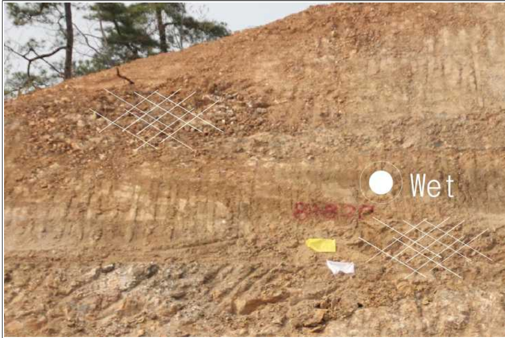
【그림 12】 A 영역 상세사진 (세편화된 암석 및 지하수 유출)
