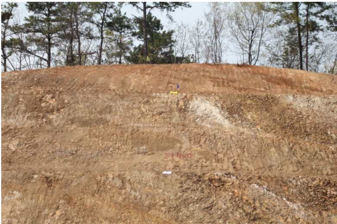
STA.8+840 상단부 녹화전
