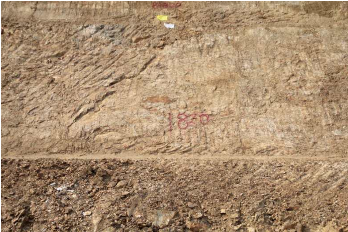
STA.8+820 하단부 녹화전
