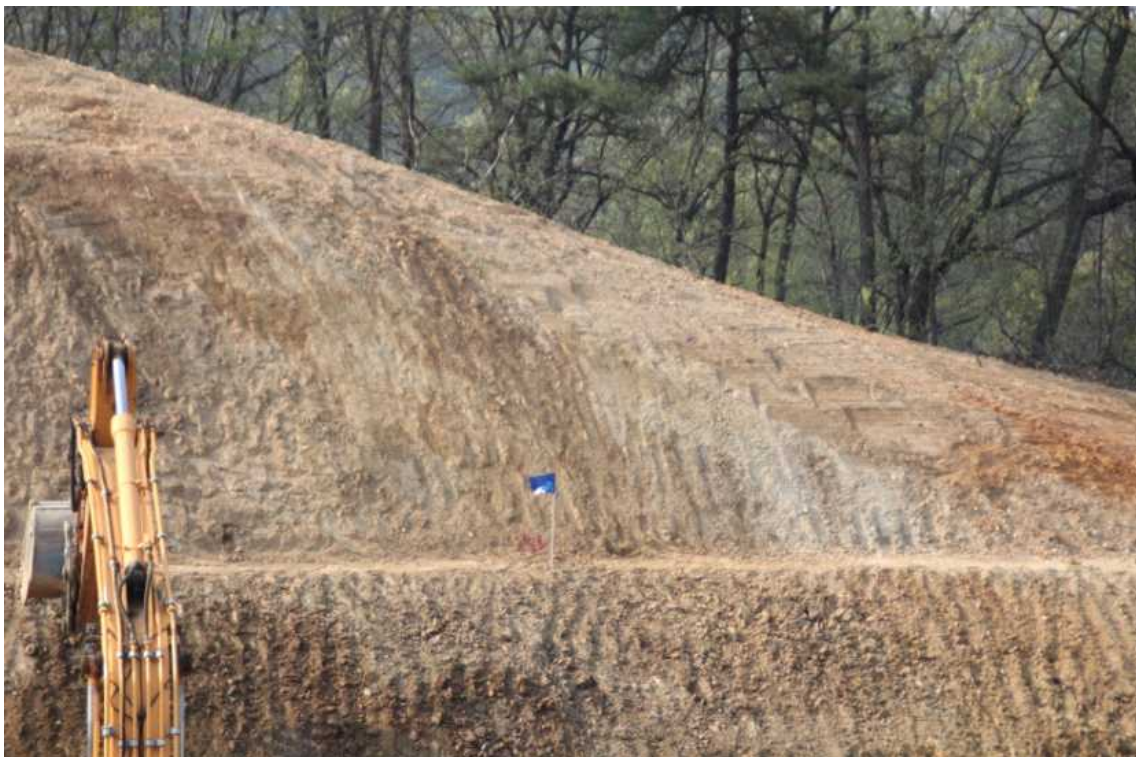
STA.8+860 상단부 녹화전
