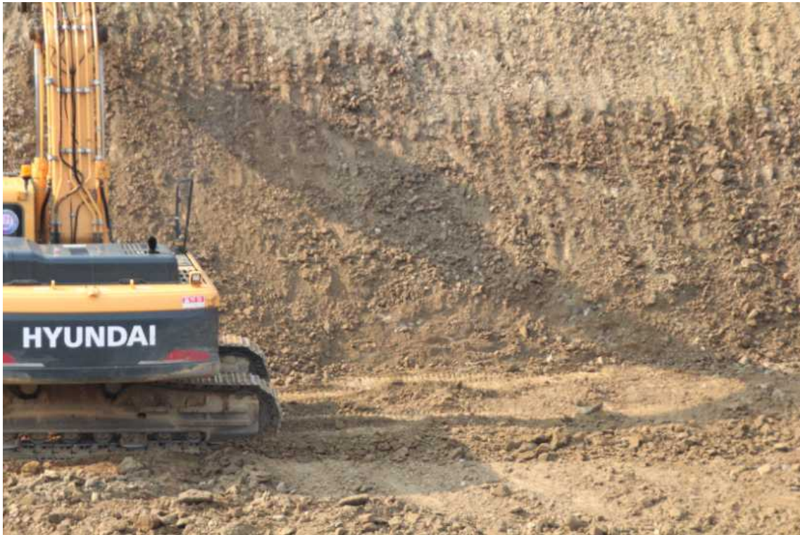
STA.8+860 하단부 녹화전
